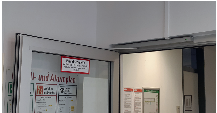
Abb. 2: Feststellereinrichtung mit integriertem Rauchbrandmelder
